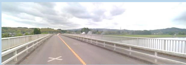
■川内川（下殿橋）を渡ります
